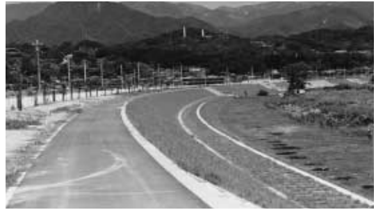
護岸完成風景
