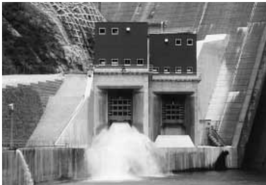
ダム下流部より新放流設備による放流状況を望む
