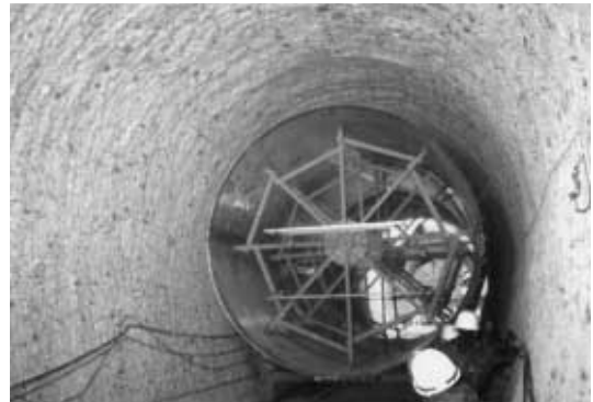
ダム堤体削孔後の放流管据付状況
