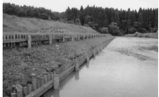
コンクリート解体材と間伐材による木柵工
