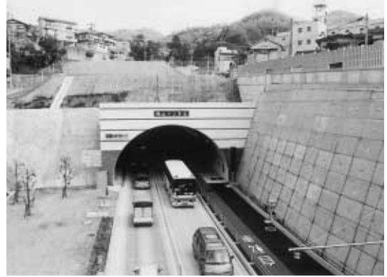
休山トンネル
