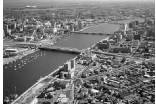
柳都大橋全景
