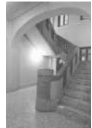
旧庁舎の階段室
