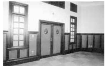
旧庁舎3階入口扉は既設使用
