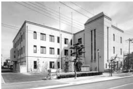
新設した玄関と増築部分
