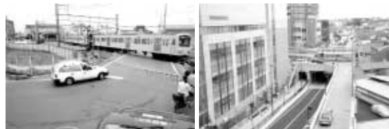
事業前(鉄道交差部の踏切) 事業後(都市計画道路の立体交差化)
