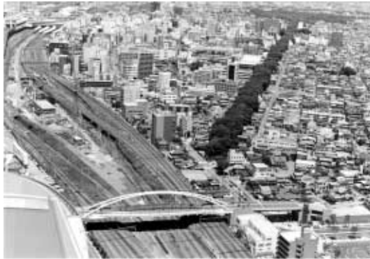
大宮ほこすぎ橋全景
