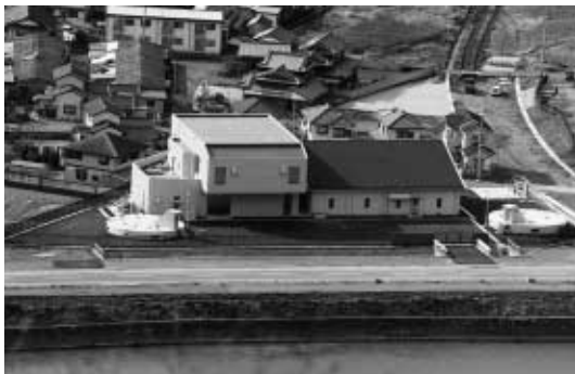
川向水源浄水施設（左の陸屋根建築が膜ろ過処理棟）
