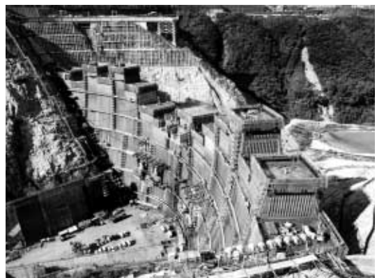
工事中の温井ダム（平成9年11月頃）
