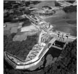
青野ダム多自然型魚道全景
