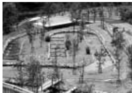
上流部魚道(ダム天端から)
