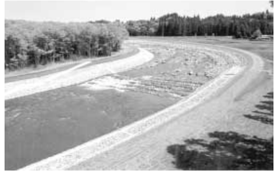
緩傾斜落差工
