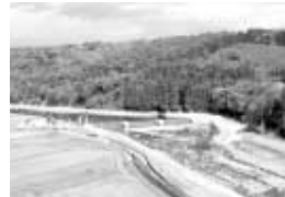
東京電力黒川発電所 余笹川取水堰
