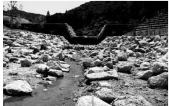
現地発生の自然石を利用した護岸工
