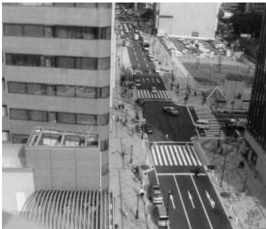
整備後の道路状況
