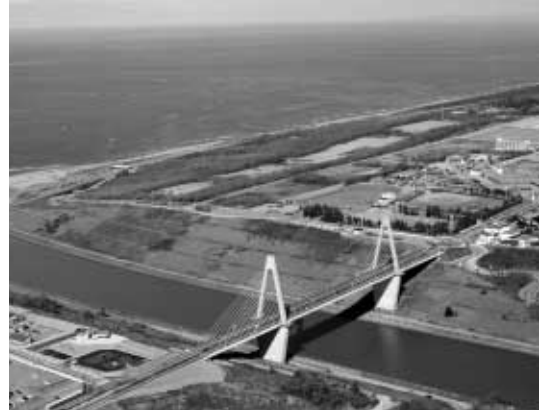
内灘大橋全景
