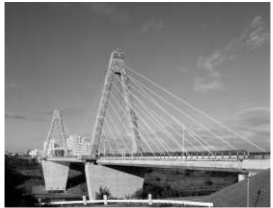
河北潟放水路に架かるPC斜張橋
