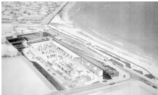
地下駐車場の全容 (休日にはバスとのセット料金の設定もあり利用促進に努めている)
