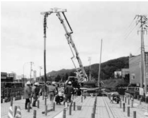
高流動コンクリートを打設中の銭函橋
