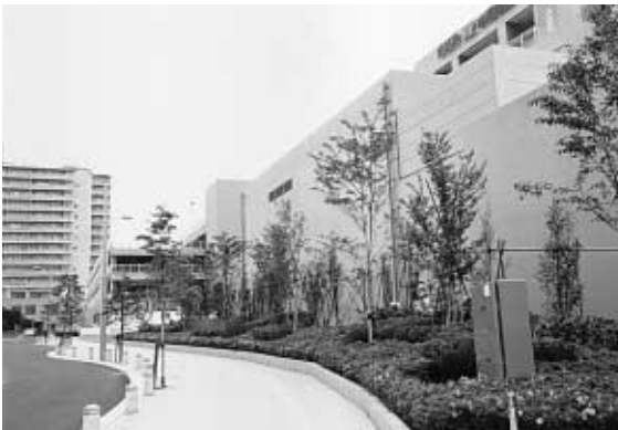
都市計画道路赤塚再開発2号線から北面を望む (手前より、病院棟・駐車場棟・複合棟)
