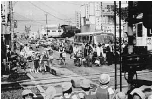
松原団地～新田駅間：県道金明町鳩ヶ谷線事業前
