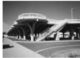
階下岸壁より人工地盤を臨む
