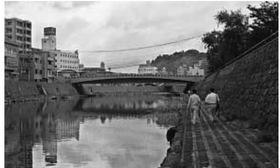
散策路として利用されている低水護岸
