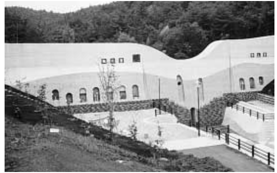
中峰谷第一砂防ダム全景
