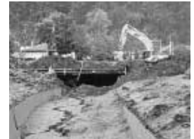
西山川流路工内堆積土の無人化施工による掘削状況
