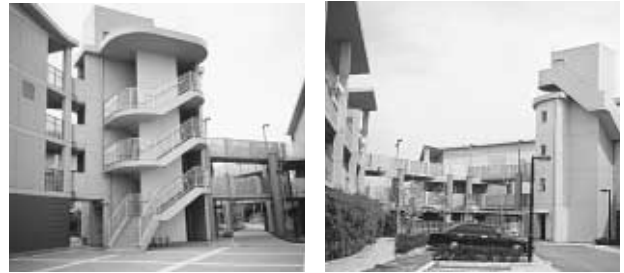
エレベーターホール3つの棟をブリッジ(空中廊下でつなぐ)
