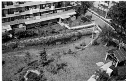
公園と一体となった河川
