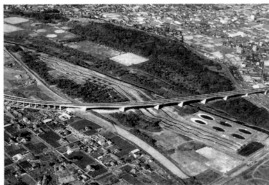
実験河川実験池全景
