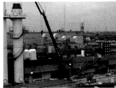
建設中の常用発電設備（金町浄水場）
