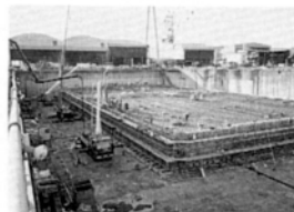
製作ドックにおけるコンクリート打設状況
