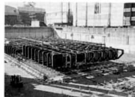
ポンツーン鋼桁の大組状況
