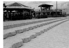
東屋及び緩傾斜式階段ブロック
