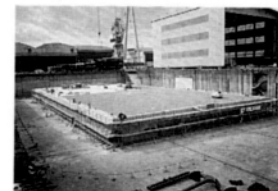
ポンツーン本体製作完了
