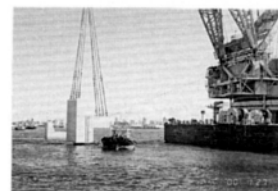
大阪港における係留ドルフィン建設状況
