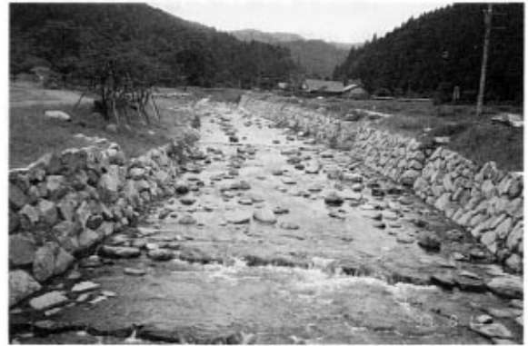
巨石積・張護岸と多段式落差工
