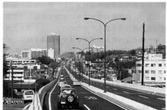
国道1号と立体交差する「平戸高架橋」
