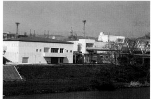
盛南大橋より中川ポンプ場を望む(中央が下水熱回収施設)
