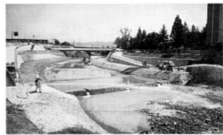
天野川防災施設全景
