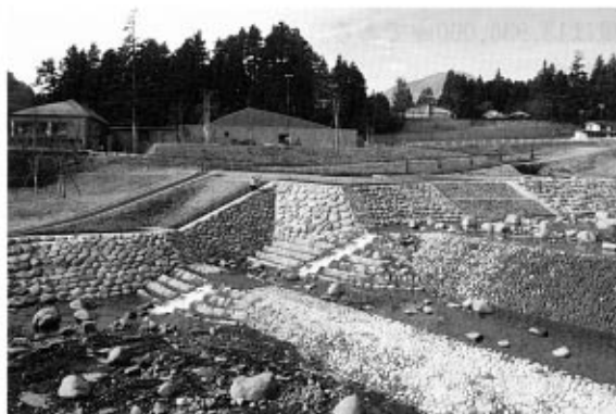
階段式魚道と石張床固工
