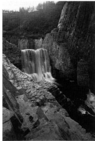
完成した七ツ釜下流砂防ダム
