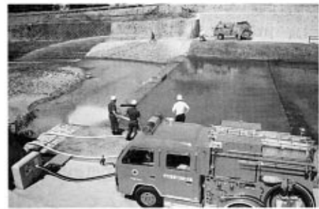
防災ピット全景
