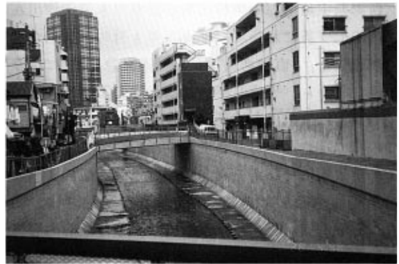
完成護岸全景
