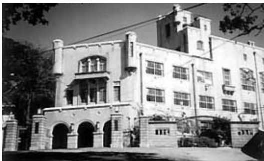
旧本館正面外観（保存改修前）
