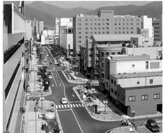
25m幅員道路俯瞰（東を望む）
