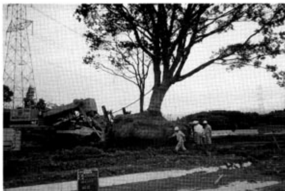
重機移植風景
