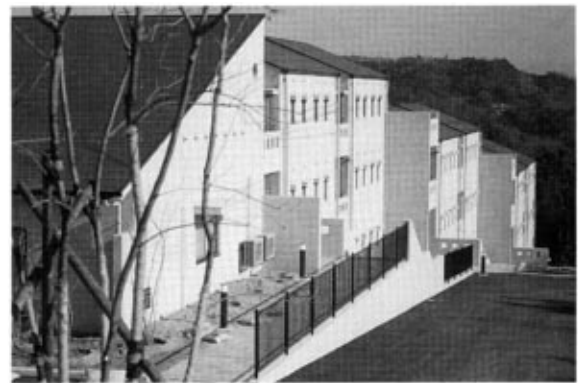
階段状に設置した「学生寮」
