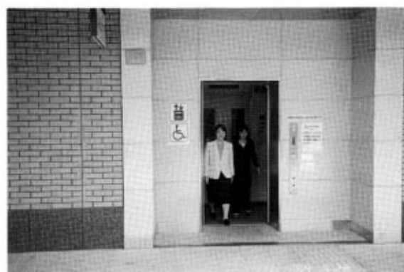
エレベータ(2方向開放扉で車椅子使用者に配慮している)
