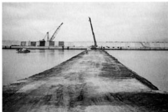
築堤完成写真
