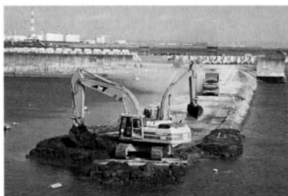
盛土施工状況
